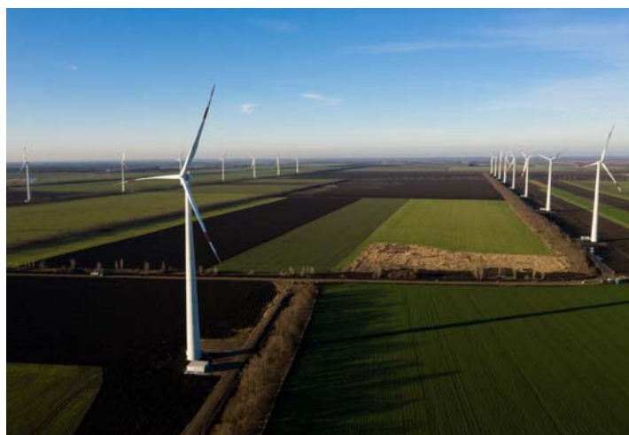
Рисунок 3. Адыгейская ВЭС. AdygeaWindfarm. Источник: zen.yandex.ru .
