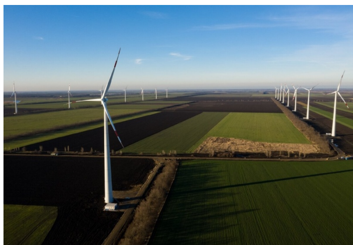
Рис. 3. / Fig. 3. Адыгейская ВЭС / Adygea Windfarm Источник / Source: zen.yandex.ru / zen.yandex.ru
