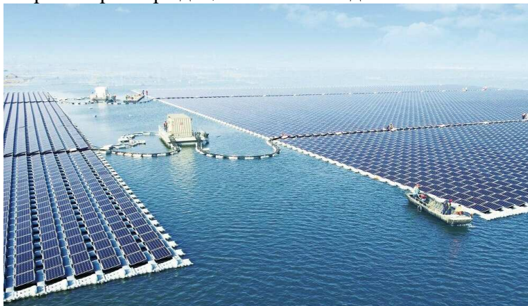
Рис. 4. / Fig. 4. Расположение солнечной электростанции в КНР на воде / The location of the solar power plant in China on the water
